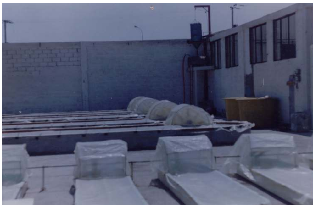
Illustration 10: Reactores de cultivo cubiertos, primer plano en fibra de vidrio, fondo en hormigón (Planta piloto en Antofagasta, 1986)
